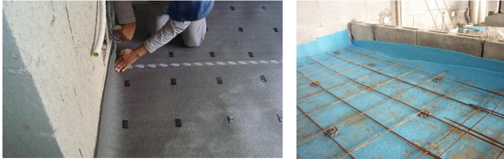
Figura 8: Colocação da manta de desconexão nos sistemas L4b e L4a
