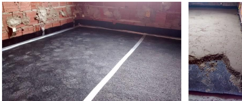
Figura 7: Colocação da manta de desconexão no sistema L3
